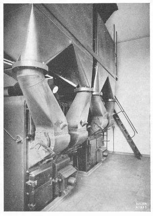
Fig. 9. — Deux chaudières Sulzer à poches en acier doux; surface de chauffe: 45 et 36,5 m², pression 6 kg/cm². L'eau surchauffée à 140°, fournie par ces chaudières, sert à l'alimentation d'appareils divers et à la préparation d'eau chaude.
