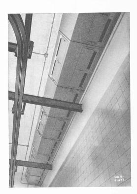
Fig. 8. — Canal d'air du frigorifique pour gros bétail, vu par dessous, composé de pièces moulées en « Eternit » coloré, avec registres de réglage.
