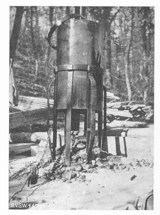
Fig. 3. — Pompe à gravier, ouverte pour l'extraction des matériaux.
