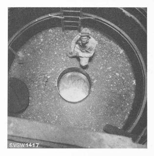
Fig. 8. — Au fond de l'avant-puits, fonçage et cuvelage terminés. Sous la surface visible, une eau limpide de 30 m, de profondeur est prête à l'exploitation.
