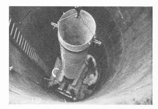
Fig. 7. — Mise en place du cuvelage définitif.
