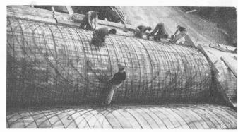
Fig. 15. — Pose des barres d'armature dans les panneaux nord.
