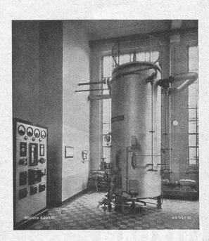
Chaudière électrique de 2 000 KW, 10 000 V, 17 kg/cm² ats.
