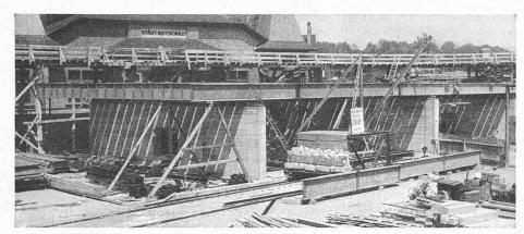
Fig. 49. — Dalles du lot 5 a portées par des parois articulées en béton armé. Poutrelles continues Die 100, renforcées par des semelles soudées en acier 44
