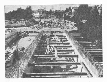
Fig. 33. — Exécution des parois longitudinales sur la partie centrale de la grande voûte.
