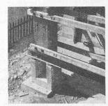
Fig. 29. — Dispositif d'abaissement de l'échafaudage à contrefiches du lot 4 (fig. 28): Assises en béton armé pour recevoir les vérins hydrauliques destinés à dégager les plaques en acier sous les pieds des échafaudages.
