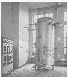
Chaudière électrique de 2000 kw, 10 000 V, 17 kg/cm<sup>2</sup> ats.
