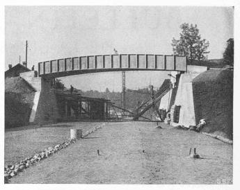
Fig. 2. — Passage supérieur métallique du «Polygonweg», portée 25 m.
