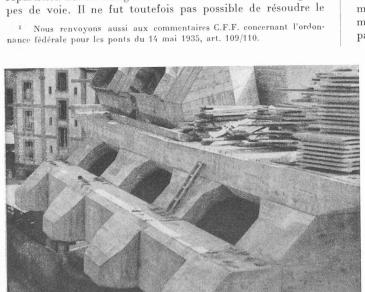
Fig. 18. — Banc d'appui, bétonnage achevé (Pile 4, lot 2).
