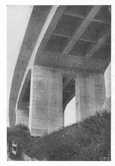
Fig. 11. — Cadre et grille portante entre les piles 9 à 11 avec tête de pile résistant à la torsion. (Organes porteurs longitudinaux et transversaux). Octobre 1939.
