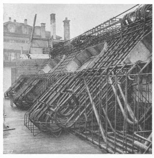
Fig. 17. — Armature d'un banc d'appui pour appuis à glissière (Lot 4).
