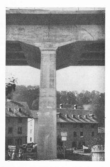
Fig. 12. — Lot 2. Pile 4 avec joint d'articulation de la poutre indépendante. La tête de la pile résiste à la torsion.
