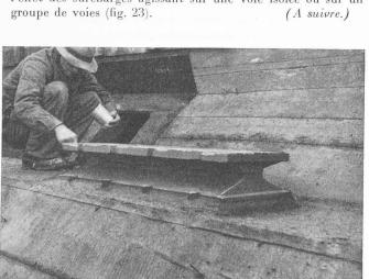
Fig. 19. — Appui fixe articulé, sur banc d'appui.
