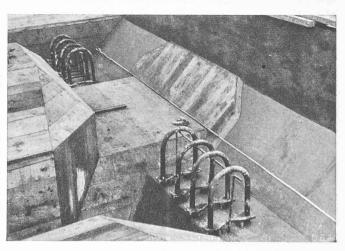
Fig. 20. — Coffrage pour les joints. Scellement des plaques d'appui articulées en acier.
