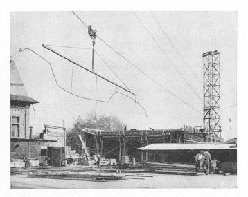
Fig. 6. — Transport par téléférique d'une pièce de fer rond de Ø 44 mm et 50 m de longueur. Ecartement des suspensions 10 m. Porte à faux 6 m.
