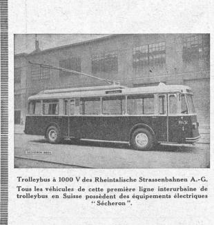
Trolleybus à 1000 V des Rheintalische Strassenbahnen A.-G. Tous les véhicules de cette première ligne interurbaine de trolleybus en Suisse possèdent des équipements électriques "Sécheron".
