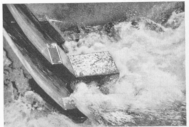
Fig. 12. — Ressaut hydraulique à l'entrée du bassin amortisseur. La vanne papillon de la vidange est logée dans le massif séparant les deux passes.
