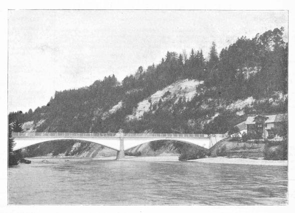
Fig. 1. — Pont sur la Thur, à Billwil. Construit en 1903. — Entreprise Maillart & Cie. Un des premiers ponts « à caisson », tympans encore pleins.
