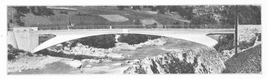
Fig. 2. — Pont sur le Rhin, à Tavasana. — Portée 52 m. — Construit en 1905. — Tympans évidés. Entreprise  $Maillart \ \& Cie.$
