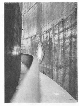
Fig. 7. — Espace entre la cuve et la paroi de la cloche. Trou d'homme de la cuve,
