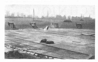
Fig. 5. — Poutrelles et tôles du fond de la cuve.
