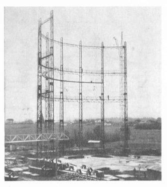
Fig. 3. — Montagé de la charpente extérieure.
