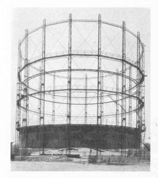
Fig. 2. — Charpente extérieure, montage du manteau de la cuve et calotte de la cloche.
