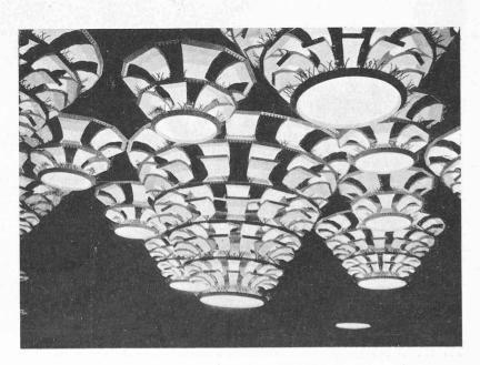
Fig. 2. — Vue rapprochée des lustres du Salon de l'automobile, à Paris, montrant la disposition des éléments diffusants et des couronnes.
