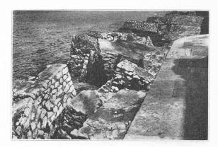
Fig. 10. — Blocs du large, de la jetée de Marseille, désagrégés, à la suite de l'attaque du mortier par l'eau de mer.
