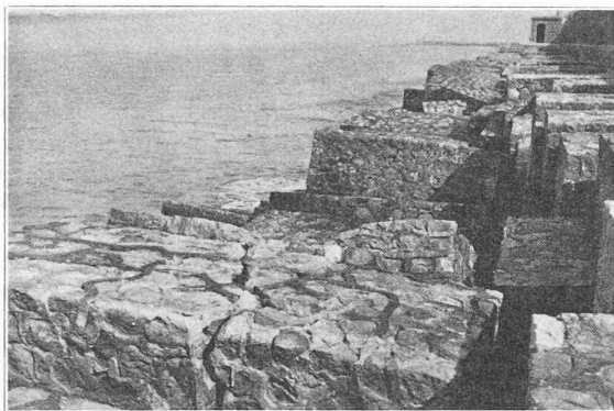
Fig. 9. — Rangée du large des blocs de la jetée de Marseille.
