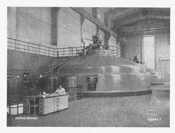
Forces Motrices de l'Aar S. A., Centrale de Klingnau. Vue partielle de deux des trois alternateurs triphasés de 19500 kVA, 10 500 V. 75 t/min, 50 p/s.
