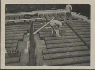
CORPS CREUX EN LIÈGE AGGLOMÉRÉ POUR PAROIS ET DALLES, PLAQUES NOIRES IMPRÉGNÉES ET COMPRIMÉES. SEMOULE ET GRENAILLE TORRÉFIÉE
