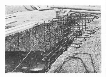
Fig. 15. — Fouille en rigole de l'anneau de fondation, momentanément remplie d'eau. Armature de l'anneau en acier Isteg.
