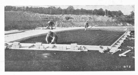
Fig. 14. — Ferraillage d'un segment extérieur de la dalle.
