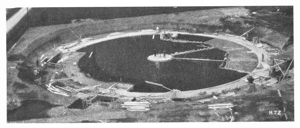
Fig. 11. — Pivot et massif central ; à l'extérieur, fin du bétonnage de l'anneau de fondation. Zone intermédiaire noire : couverture de mâchefer roulé ; deux segments de la dalle sont bétonnés, deux autres, délimités.
