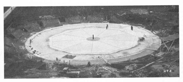
Fig. 12. — Fin des fondations du gazomètre ; on nettoie la dalle qui vient d'être glacée, avant de l'enduire d'Igol.
