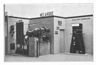
Fig. 8. — Groupe d'essai des roues hydrauliques rapides, parois en place ne laissant visibles que la turbine et son alternateur. A gauche, les appareils de commande à distance et le tableau des piézomètres de mesure.
