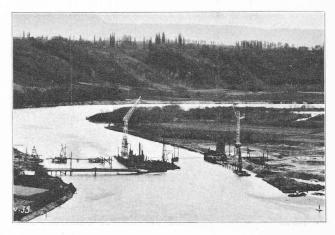
Fig. 14, — Vue du chantier de l'usine-barrage, prise de l'amont, en avril 1939. Construction du batardeau de la pile III et du premier batardeau de la rive droite.
