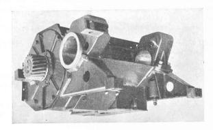
Fig. 7. — Moteur monophasé 240 PS, à carcasse entièrement soudée.
