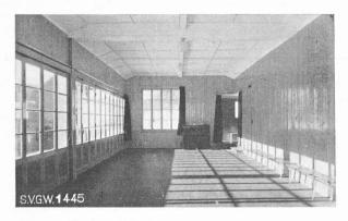
Fig. 8. — Salle de gymnastique, à Chesières. Bouche de soufflage et thermostat visibles contre la paroi de droite.
