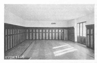
Fig. 9. — Salle de jeux de l'Institut Beau-Soleil, à Villars s/Ollon. Bouche de soufflage dans la paroi du fond. Bouche de reprise dans l'armoire ouverte.
