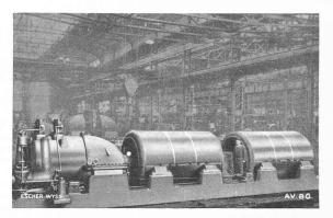
Fig. 12. — Groupes turbo-compresseurs de transformation de vapeur, 20 000 000 Cal/h., 40 000 kg de vapeur comprimés par heure.
