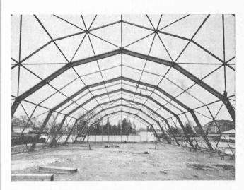
Halle des fêtes. Fig. 8. Cette vue fait ressortir la simplicité du schéma de la construction et la légèreté des éléments porteurs. Les dimensions sont mises en évidence par les ouvriers qui sont
