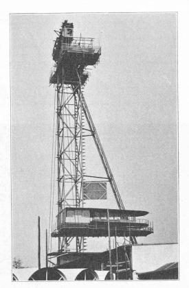
Fig. 6. — Pylône du téléférique. Cette vue d'ensemble fait ressortir la forme de la plate-forme supérieure débordant largement de chaque côté de la tour. Remarquer la longueur des barres du treillis qui souligne le schéma de la construction, en évitant de donner l'impression de fouillis que d'aucuns reprochent aux constructions métalliques.
