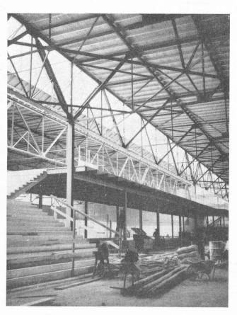
Fig. 3. — Halle « Fers, métaux, machines ». Cette vue montre plus particulièrement les deux poutres maîtresses courant sur toute la longueur de la face des portes des deux hangars d'aviation juxtaposés. Ces poutres sont-surmontées par le lanterneau central (voir fig. 2).
