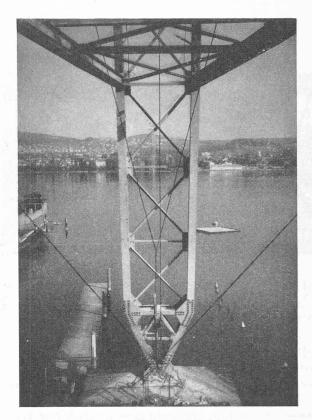
Fig. 7. — Pylône du téléférique. Vue montrant la partie inférieure de la contrefiche. On remarquera que tous les assemblages sont boulonnés, en vue du démontage à la fin de l'exposition.
