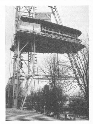
Fig. 5. — Pylône du téléférique. Vue de la plate-forme du restaurant, avec le pont provisoire de montage qui masque toute l'ossature du plancher.
