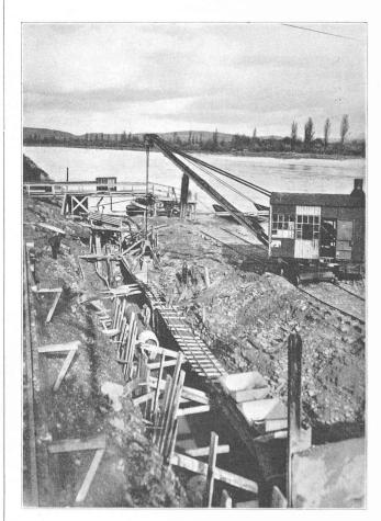
Fig. 21. — Drainage derrière le mur de rive gauche aval. Photo Dyckerhoff et Widman (Berlin).
