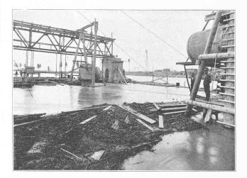
Fig. 20. — Fouille du seuil 4 inondée lors d'une crue du Rhin. Au premier plan : matériaux charriés par le fleuve. Photo Dyckerhoff et Widmann (Berlin).
