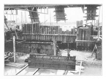
Fig. 19. — Montage du caisson métallique du parafouitle aval du seuil 2.
