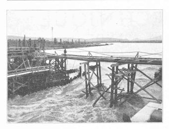
Fig. 17.— Plancher de montage de la première travée du pont provisoire menacé par une crue du Rhin.
