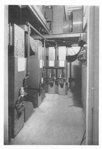
Fig. 6. - Chaufferie du théâtre de Vevey. Générateurs Strack-Cipag. Constructeur: Cipag S. A., à Vevey.
