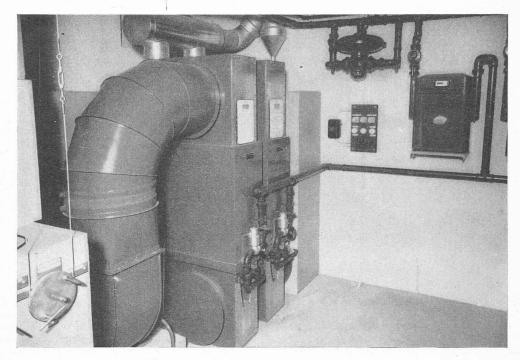
Fig. 3. — Chaufferie du temple de Clarens. Générateurs système Strack-Cipag (Arthur Martin, constructeur).
