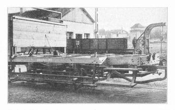
Fig. 15. — Bogie à un seul essieu, système V. R. L., avec appareil d'enregistrement. Commande parallèle du châssis par-dessous.
