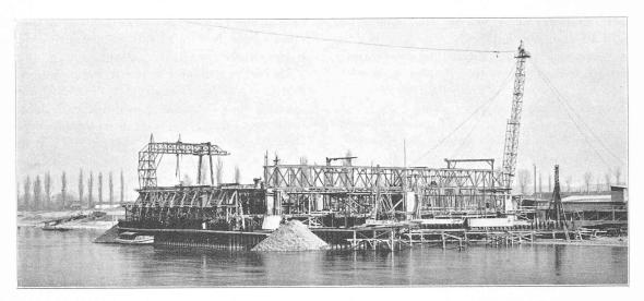
Fig. 14. — Travaux de la rive droite du Rhin, au début de 1930. — A gauche : Echafaudage du caisson de la pile III. Photo Dyckerhoff et Widmann (Berlin).
