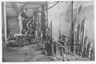
TONHALLE ZURICH Consolidation des fondations avec des injections de ciment et des injections chimiques. TRAVAUX HYDRAULIQUES S. A. Christoffelgasse 2
