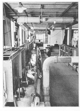
Fig. 7. — Vue de la canalisation d'essai. Cas de la conduite de 100 mm en « zig-zag ». A. Canalisation d'essai; B. Tubes raccordant les prises de pression au tableau piézométrique ; C. Prises de pression (voir fig. 1) placées au milieu de chaque élément de 2,50 m de long ; D. Joint Gibault (voir Fig. 1) ; E. Tableau piézométrique (voir Fig. 2).
