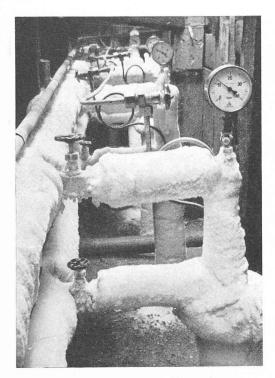
Fig. 8. — Tubes congélateurs  $N^{\rm os}$  8 à 12, placés au fond d'une fouille de 4,50 m de profondeur.
