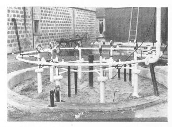
Fig. 4. — Installation pour réalisation d'un puits circulaire de 2,50 m de diamètre et 5 m de profondeur (8 tubes congélateurs, un puits filtrant central et 7 tubes pour mesures de températures).
