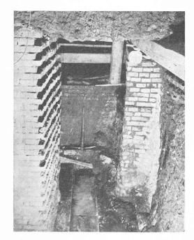
Fig. 18. — Vue des travaux de reprise en sousœuvre après pompage à l'intérieur de l'enceinte. (Le socle sur lequel s'élevait l'Ara Pacis est visible en bas à gauche.)
