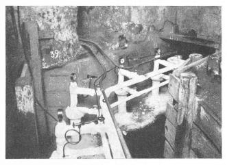
Fig. 13. — Tubes congélateurs dans le sous-sol du bâtiment ( $N^{\rm os}$  38 à 41) et arrivée des conduites principales d'alimentation en  $CO^2$  liquide.
