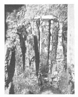
Fig. 17. — Pieux de châtaignier, en partie décomposés, servant de fondation à certaines parties des bâtiments existants.
