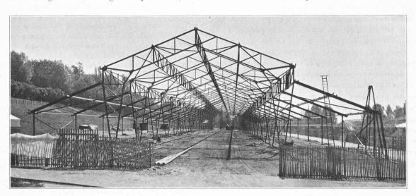
Fig. 1. — Vue de la halle centrale montrant le système constructif comprenant les fermes et les pannes à treillis. Les séparations des éléments sont marquées par les goussets d'attache aux membrures.
