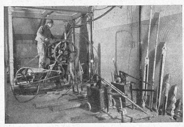
TONHALLE ZURICH Consolidation des fondations avec des injections de ciment et des injections/chimiques.
