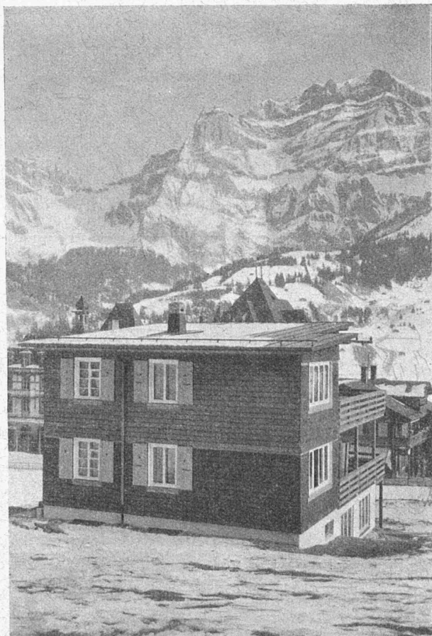
Chalet à Adélboden (altitude env. 1400 m.) couvert avec TECUTA 0,40 mm.
