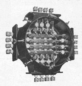
Boîte de distribution souterraine basse tension avec coupe-circuits à haut pouvoir de rupture ou sectionneurs.
