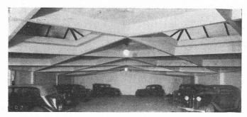
Fig. 3. — Grand garage à Dusseldorf ; 16 m  $\times$  25 m de surface couverte, dalle de 5 cm, poutres 12/50, armature 8 kg/m² (dont ²/3 acier Isteg).
