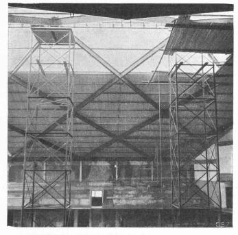
Fig. 5. — Toiture de hangar entièrement soudée avec double couverture et tribunes suspendues pour une patinoire artificielle à Blackpool (Lancashire); portée libre de  $40,5~\mathrm{m}\times46~\mathrm{m}$ , montage des pièces profilées sans usinage préalable aux ateliers sur échafaudages métalliques provisoires.
