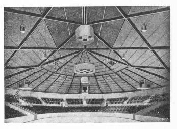
Fig. 6. — La poutraison diagonale apparente composée de P. N. 45 cm d'un hangar à Blackpool, portée vide de 40,5 m  $\times$  46 m. Quantité de fer utilisée 32 kg/m², y compris toutes les pannes, poutres, etc. Construction libre de toute poussée horizontale.
