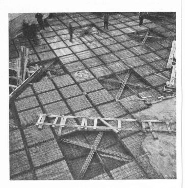
Fig. 1. — Plancher continu en béton armé d'une usine à Mannheim ; distance des appuis 6 à 9 m. I es porte à faux des colonnes, parallèles aux murs forment les appuis des poutraisons en diagonale. Les surfaces sur les appuis sont bétonnées en plein ou munies de semelles inférieures. Epaisseur fictive de la dalle également répartie 10 cm, poutres 12/25 cm, fers ronds 11 kg/m².
