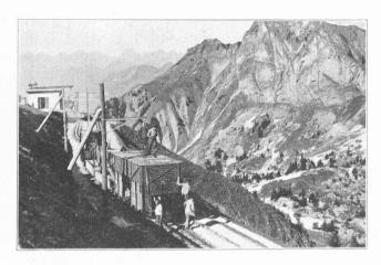
Fig. 6. — Tirage des fils de contact à la gare de Jaman.
