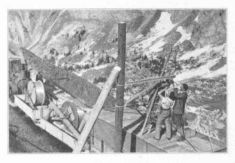
Fig. 7. — Tirage des fils de contact, entre Jaman et Naye.
