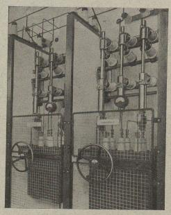
Cellules 10 kV avec disjoncteurs à bain d'huile et sectionneurs autopneumatiques.
