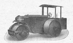
Rouleaux-compresseurs trijante Diesel 3-14 tonnes
