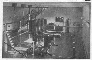
Disjoncteurs pneumatiques Type AF8 - 50 kV 750 MVA dans la centrale électrique de l'Albula.
