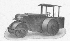
Rouleaux-compresseurs trijante Diesel 3-14 tonnes
