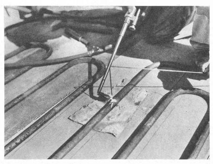
Fig. 3. — Soudure des serpentins posés sur le coffrage.
