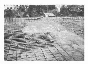
Fig. 4 -- Vue des serpentins et de l'armature des dalles en béton.
