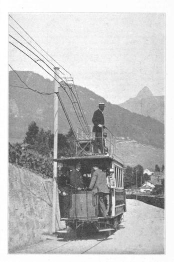
Fig. 2. — Ancienne ligne de traction et ancienne voiture du tramway Vevey-Montreux. — Année 1888.
