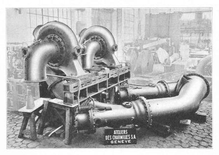
Fig. 10. — Groupe des turbines, avec vannes et collecteur.
