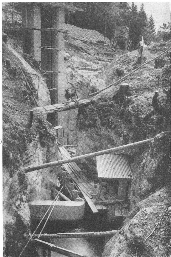
Fig. 3. — Vue de la gorge, avec le batardeau et le chenal de dérivation ; dans le fond, prise d'eau en construction.
