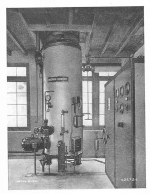
Fig. 4. — Fédération laitière du Léman, à Vevey. Installation d'une chaudière électrique, 800 kW, 4000 V, 8 kg/cm² de pression absolue.
