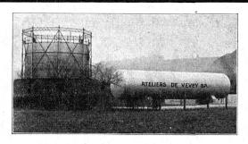
Capacités utiles comparées  $\begin{cases} gazomètre & 500 \text{ m}^3 \\ réservoir & 800 \text{ m}^3 \end{cases}$
