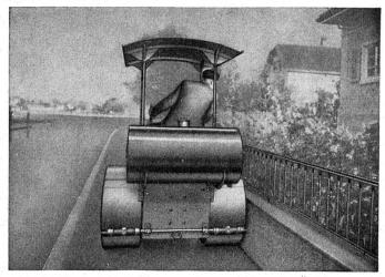
Rouleaux trijantes Diesel jusqu'à 12 tonnes.
